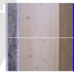
SK předstěna s ovčí vlnou OSB nebo SV deska vláknitá izolace [minerál, vlna] cířevláknitá deska omítka
